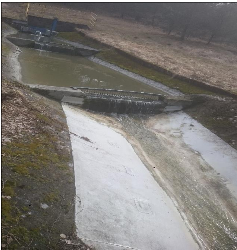
Ryc. 9. Wylot ścieków przemysłowych.
