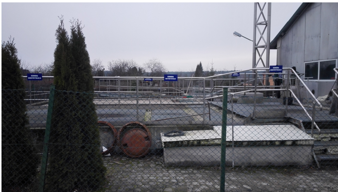
Zdjęcie nr 2: Oczyszczalnia ścieków komunalnych w miejscowości Łubiana – eksploatowaną przez „Lubeko” Sp. z o.o – komora denitryfikacji
