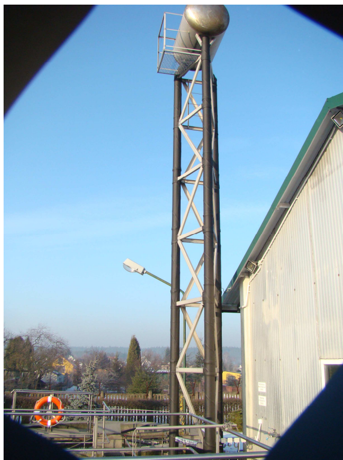
c) Zbiornik próżniowej modyfikacji osadu; rozdzielnica RZS wraz z kab. grzejmym szt. 1
