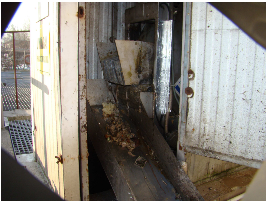
b) Krata schodkowa; rozdzielnica RZS wraz z kablem grzejmym
